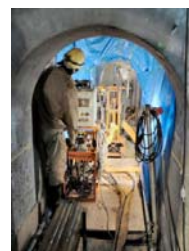
狭隘部の施工
