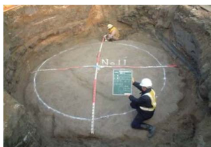
出来形の例 (直径5.0m)
