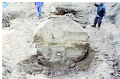
掘り出した注入固結体
