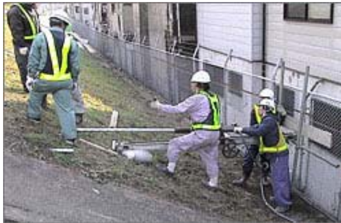
地下水排除工の例
