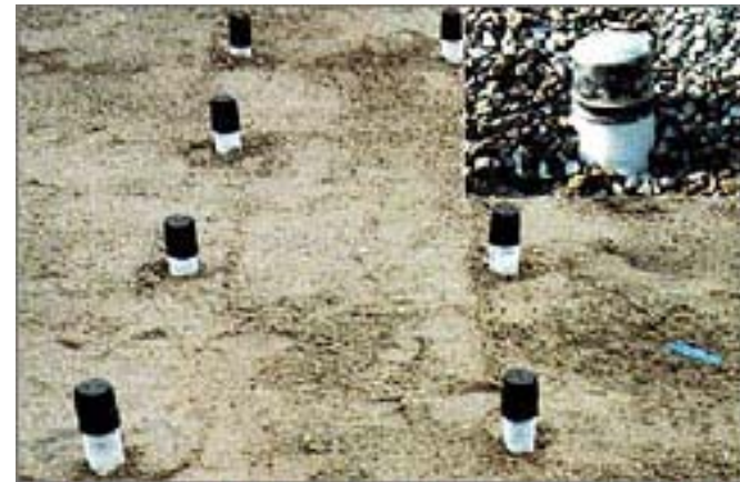
過剰間隙水圧消散工の例
