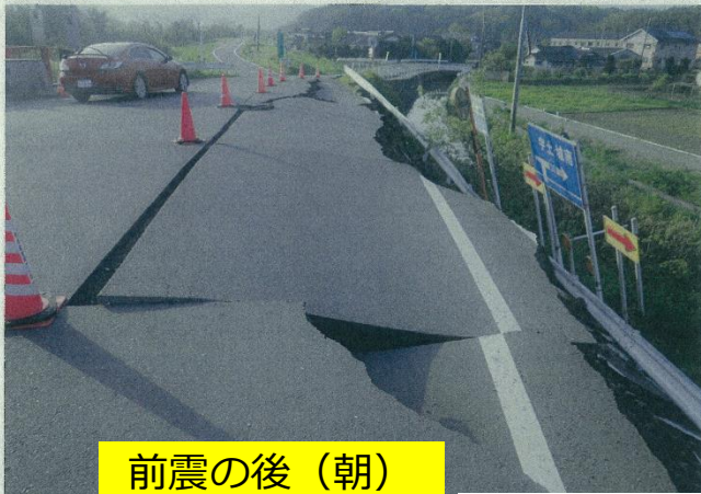
緑川左岸20k700付近 乙女橋
