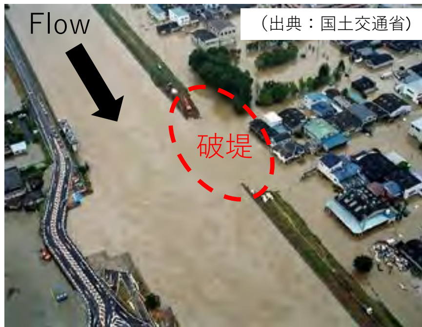
東海豪雨での新川破堤箇所
