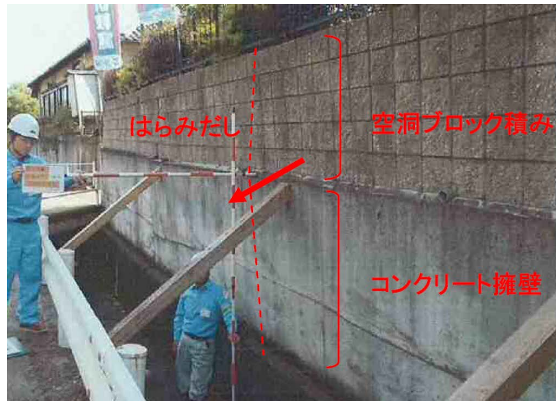
増し積み擁壁境界部のはらみだし
