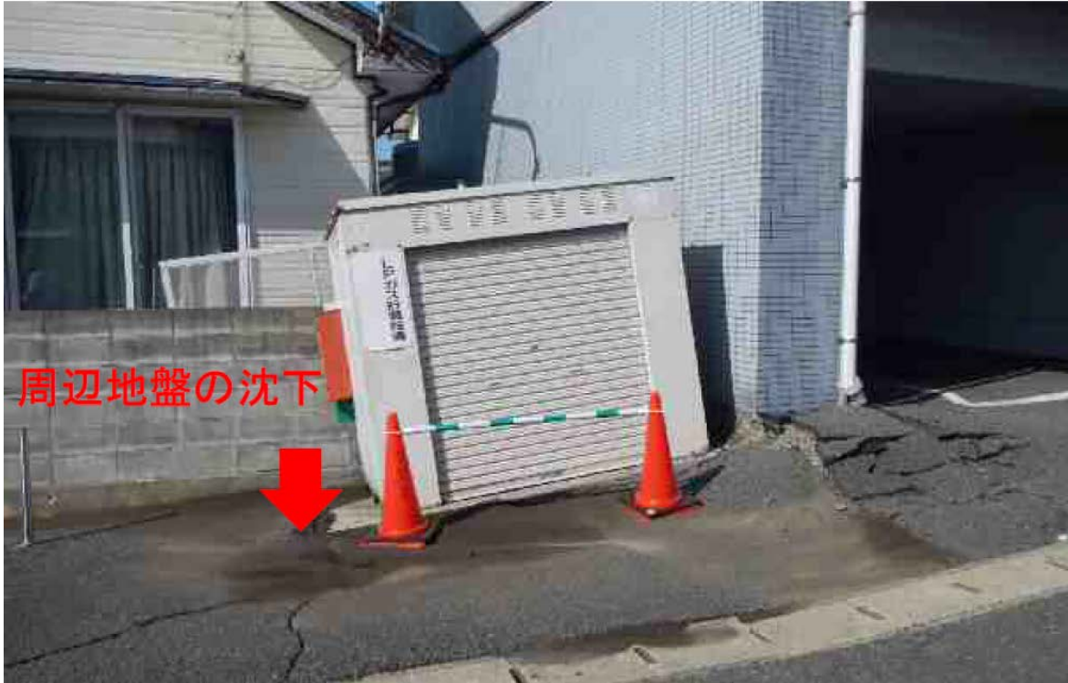
宅地地盤の沈下
