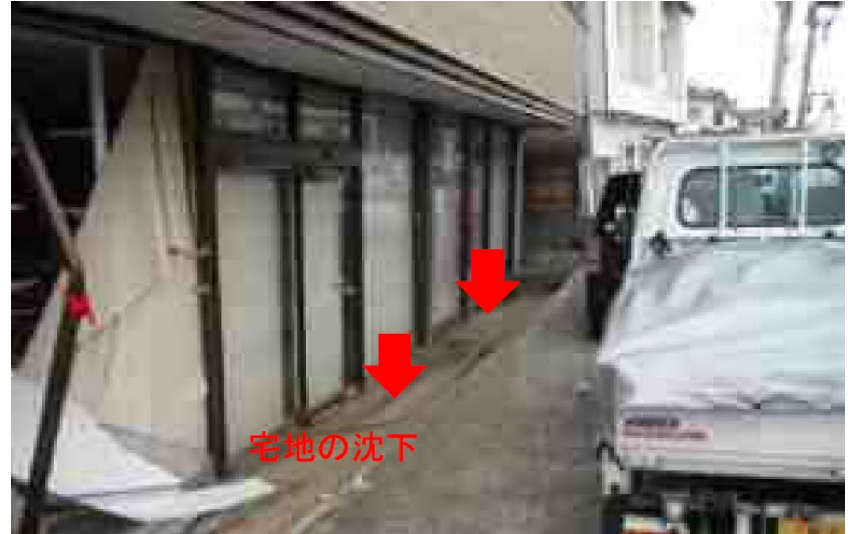
宅地の沈下による道路との段差
