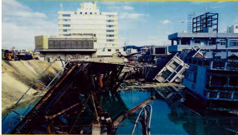
事故の原因究明:崩壊影響範囲外で追加地盤調査。表土と砂質土が4m。
