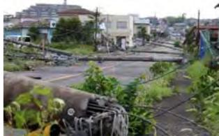
電柱が倒壊して道を塞ぐ(泉南市)
