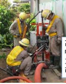
噴射攪拌工法の超小型施工機
