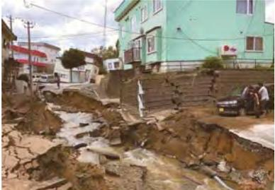
**液状化を伴う地盤沈下(札幌市清田区)**
