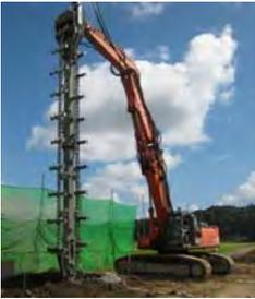
深層混合処理工法の小型施工機
