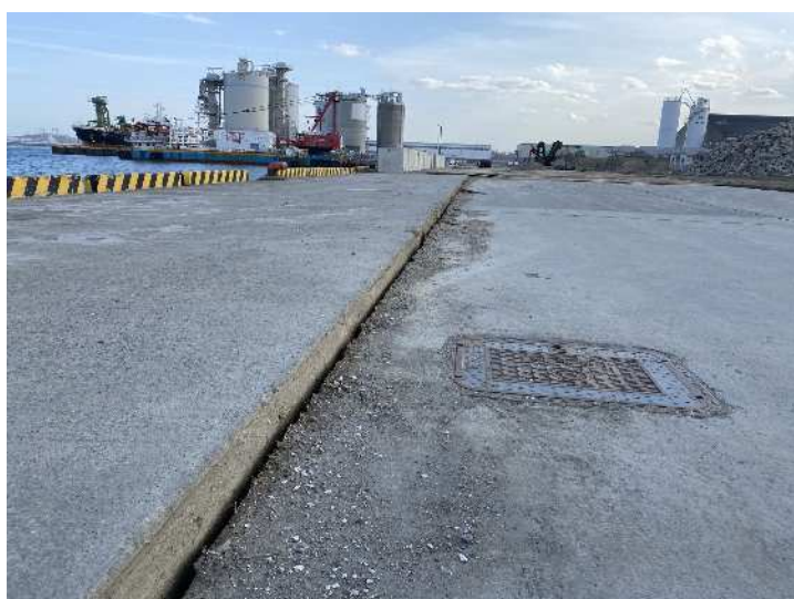
岸壁に生じた段差
