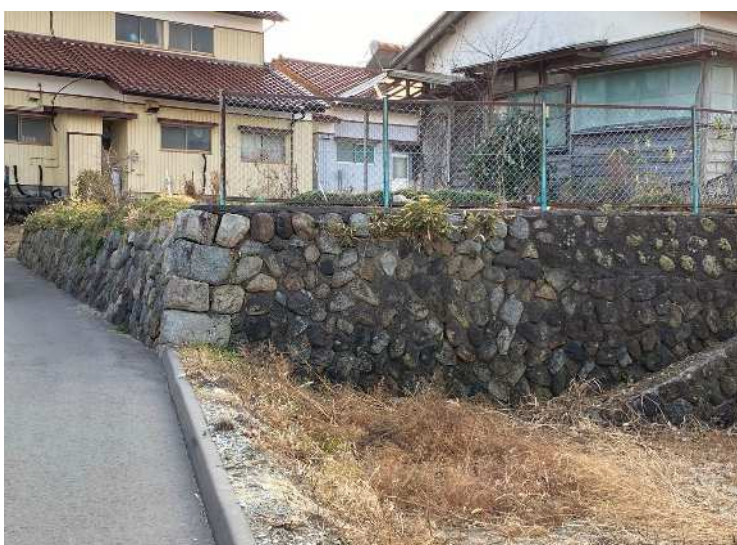
空石積み擁壁
