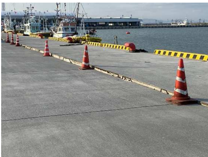
岸壁に生じた段差
