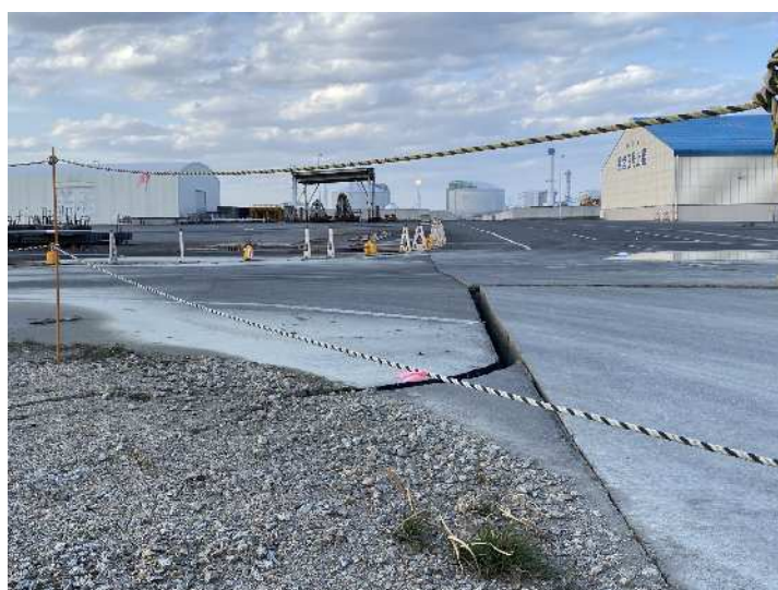
港湾内の道路に生じた亀裂
