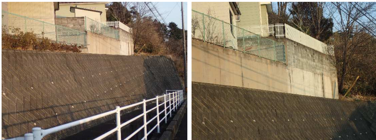
3段増し積み擁壁
