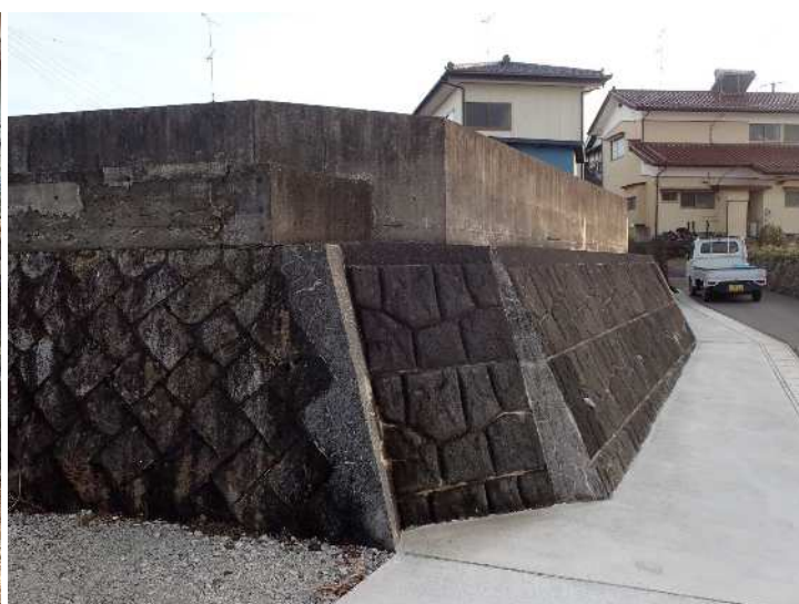
増し積み擁壁
