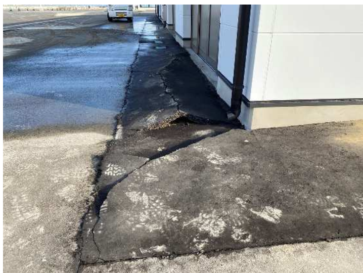
圧縮力による舗装の隆起
