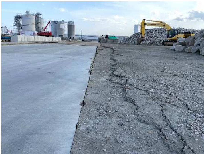
岸壁背面用地内に生じた亀裂
