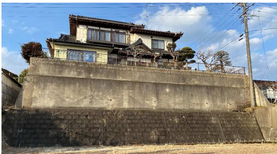
増し積みの不適格擁壁であるが、震度6強の地震でも無被害であった
