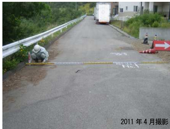
写真-1 本宮市の造成団地の谷埋め盛土箇所の変状
