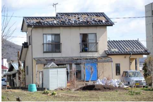
写真-3 国見町の国道4号沿いの人家の屋根瓦の落下とビルの傾斜(転倒の危険有り) 国見町役場に聞き取りを行ったところ、傾斜が生じた日時は不明とのことであった。 現在は、解体作業の準備が進められている。
