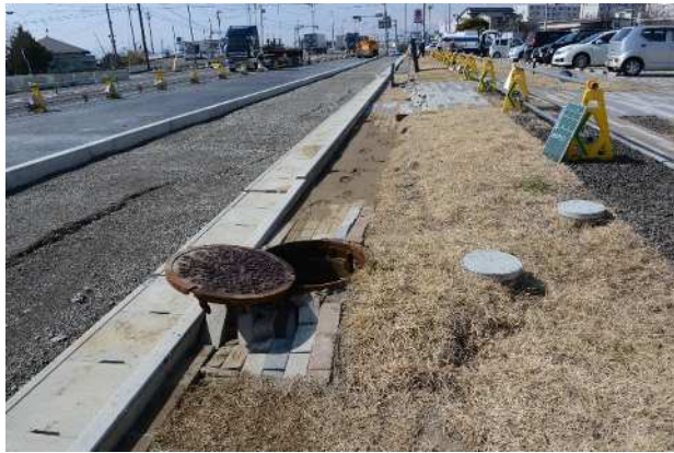
国見町役場前の緑地帯に埋設されているマンホールの浮き上がりと噴砂状況
