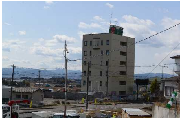
写真-3 国見町の国道4号沿いの人家の屋根瓦の落下とビルの傾斜(転倒の危険有り) 国見町役場に聞き取りを行ったところ、傾斜が生じた日時は不明とのことであった。 現在は、解体作業の準備が進められている。
