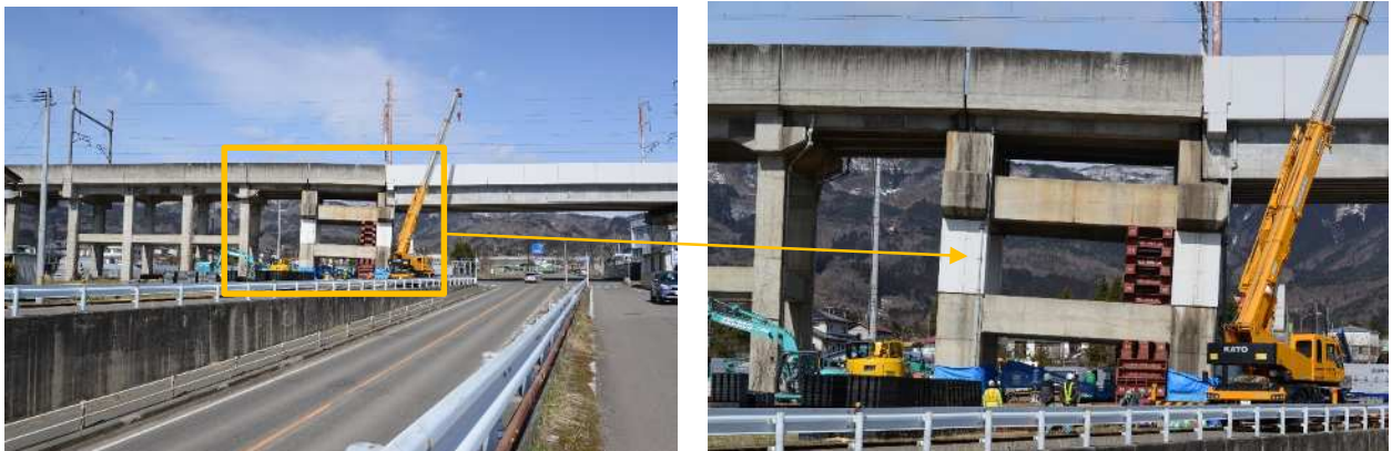
写真-2 国見インターを出てすぐの新幹線高架橋の傾斜 (東北新幹線では、3月21日現在1000か所の損傷が確認された)
