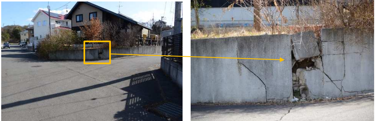
写真-1 本宮市の造成団地の谷埋め盛土箇所の変状
