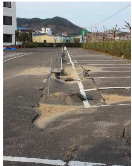
2011年4月に撮影した旧国見町役場駐車場に埋設されていた下水管渠及びマンホールが液状化による変状
