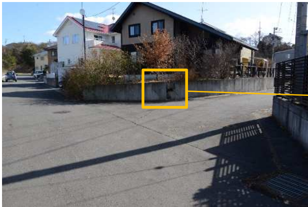
写真-1 本宮市みずきヶ丘団地の谷埋め盛土箇所の変状 (東日本大震災において変状した箇所でもある)
