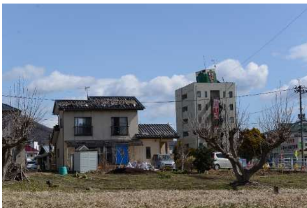
写真-3 国見町の国道4号沿いの人家の屋根瓦の落下とビルの傾斜(転倒の危険有り)
