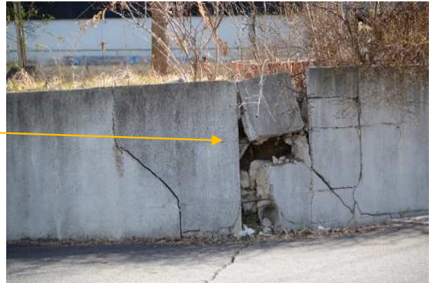
写真-1 本宮市みずきヶ丘団地の谷埋め盛土箇所の変状 (東日本大震災において変状した箇所でもある)
