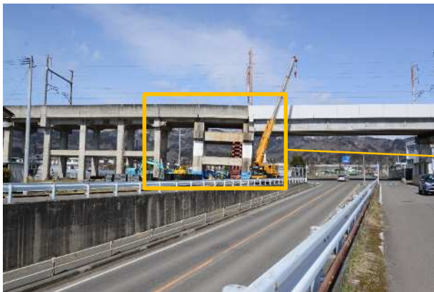
写真-2 国見インターを出てすぐの新幹線高架橋の傾斜 (東北新幹線では、1000か所の損傷が確認された)
