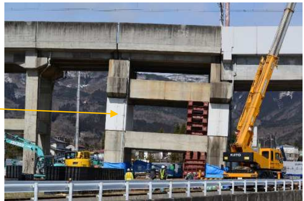
写真-2 国見インターを出てすぐの新幹線高架橋の傾斜 (東北新幹線では、1000か所の損傷が確認された)
