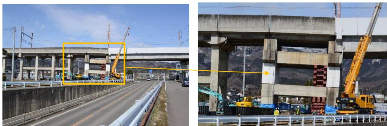
写真-2 国見インターを出てすぐの新幹線高架橋の傾斜
