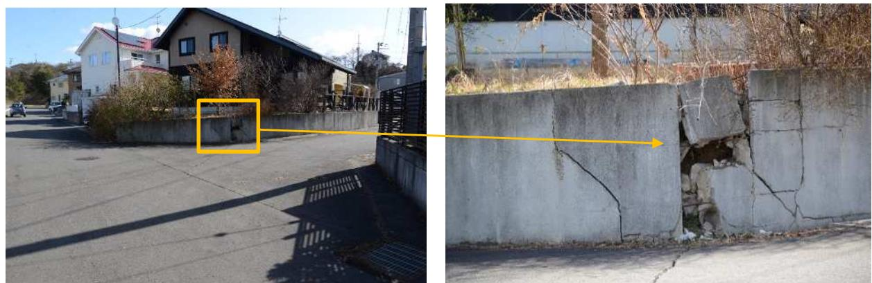
写真-1 本宮市の造成団地の谷埋め盛土箇所の変状
