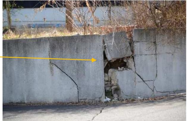
写真-1 本宮市の造成団地の谷埋め盛土箇所の変状
