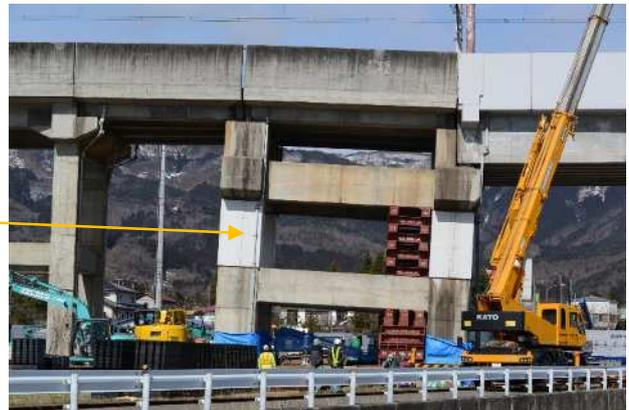
写真-2 国見インターを出てすぐの新幹線高架橋の傾斜
