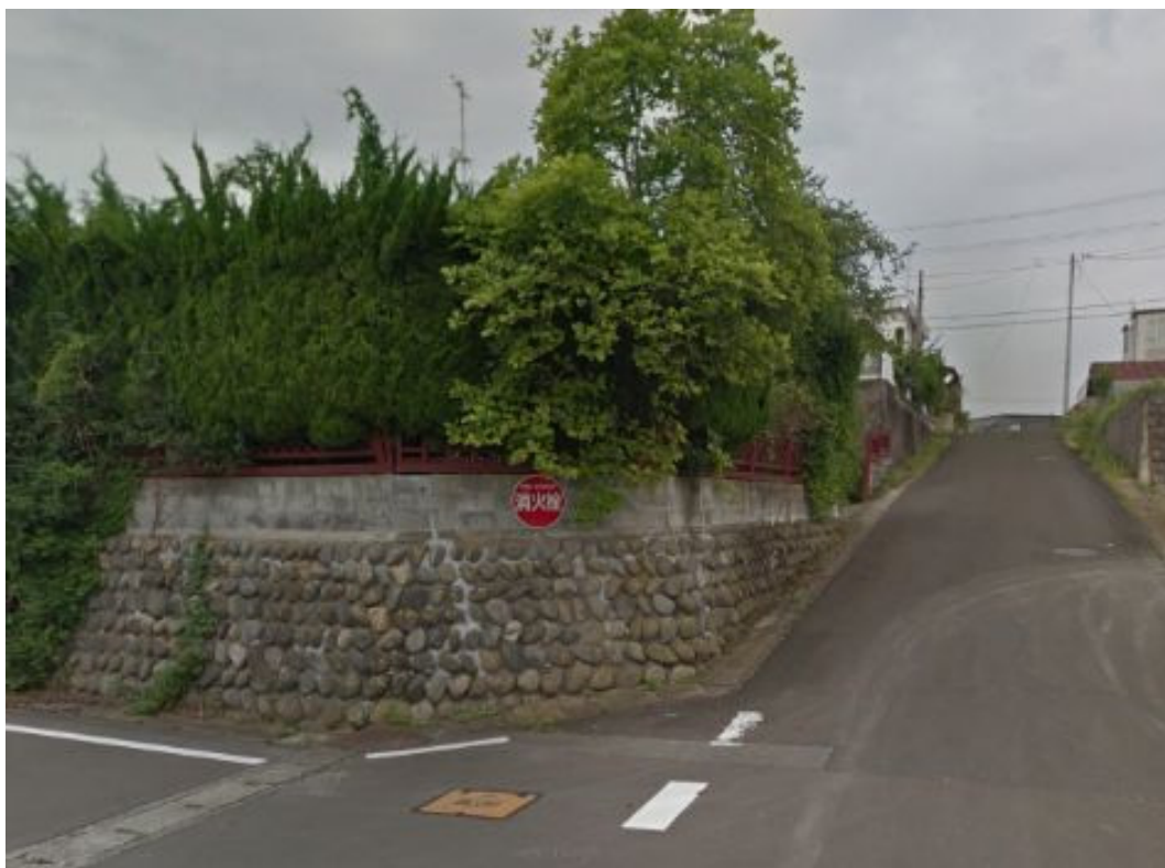
被災前の状況（2017年8月撮影）※Google ストリートビュー ※玉石積擁壁に補修跡がみられるが、2021年2月の地震では崩壊していない
