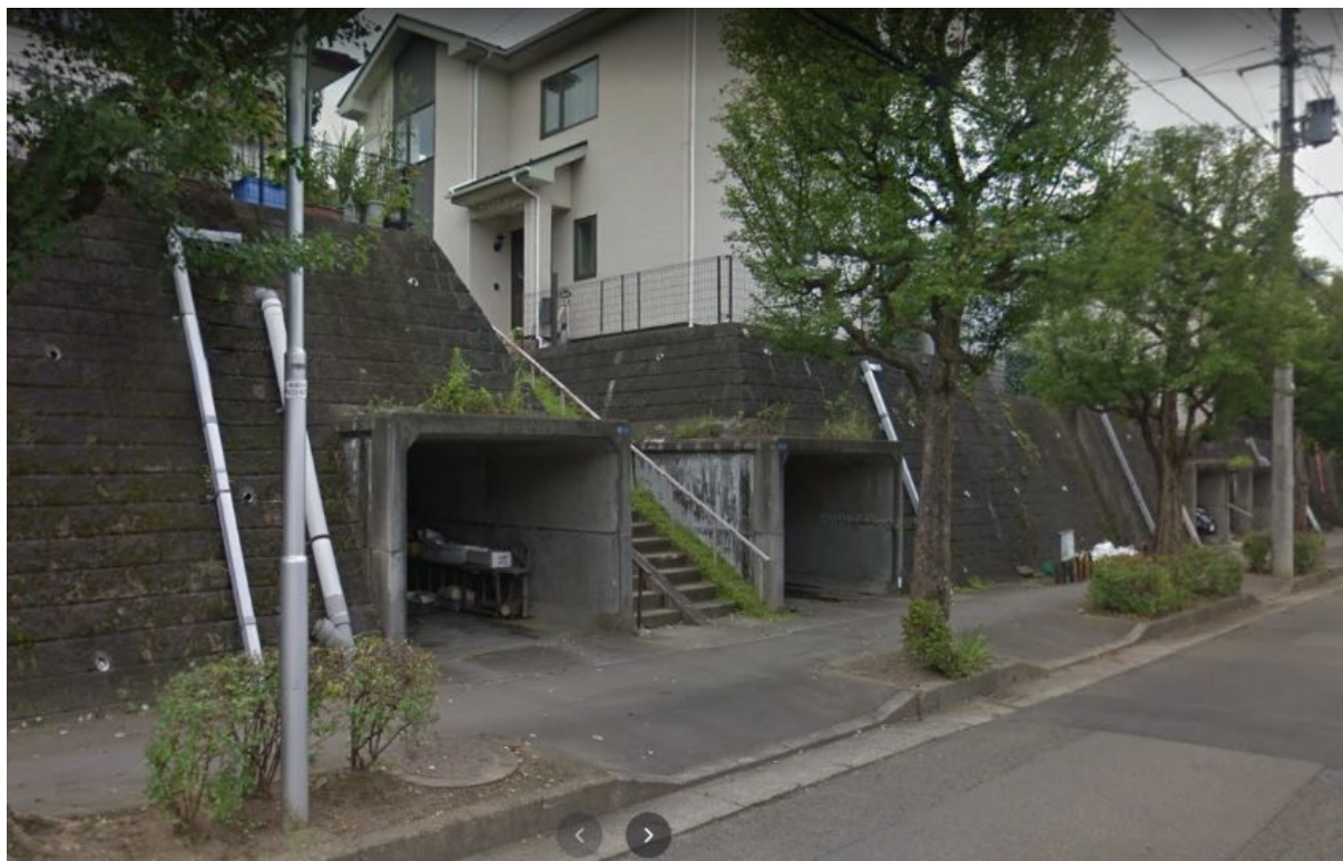
2021 年 5 月撮影（Google ストリートビュー）※歩道部に変状無し
