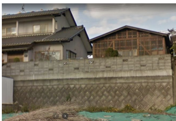
東日本大震災後の状況（2011 年 11 月撮影） ※Google ストリートビュー
