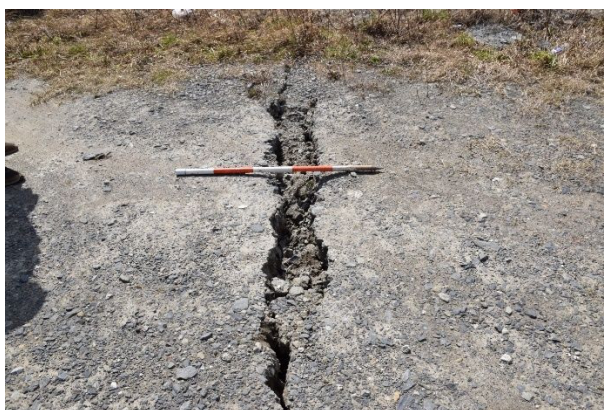
護岸の変状および護岸背面地盤の亀裂 ※噴砂は確認できず
