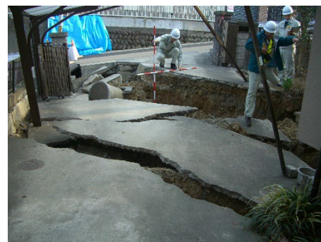
2011年東日本大震災における仙台市内の大規模盛土造成地の被災状況
