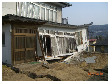
2011年東日本大震災における仙台市内の大規模盛土造成地の被災状況
