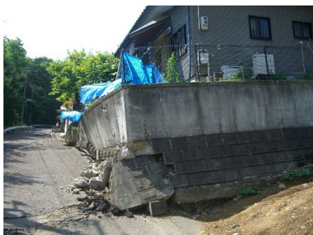
2011年東日本大震災における仙台市内の大規模盛土造成地の被災状況
