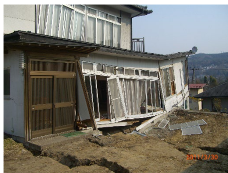
2011年東日本大震災における仙台市内の大規模盛土造成地の被災状況
