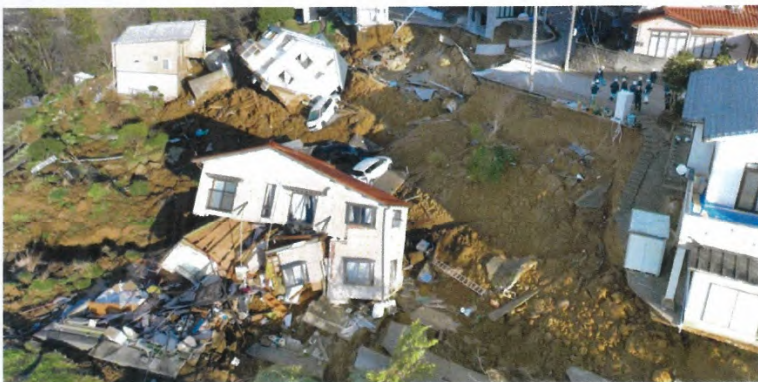
【写真2】金沢市田上新町での盛土崩壊
