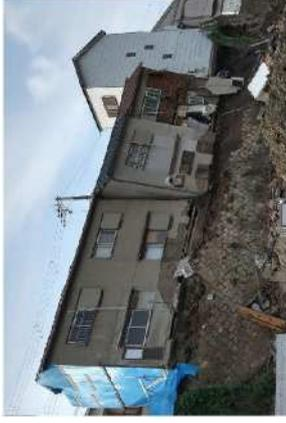
【図2】裏込め土の流失で擁壁上部が倒壊したか？
