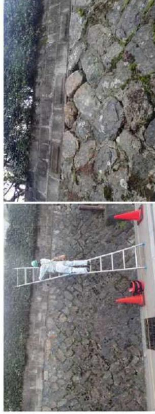
擁壁+ブロック塀の高さが高すぎると例 (空積み擁壁を基礎としている点でもアウト。ただし、ブロック塀単体は高さが60cmしかなく、建築基準法上は基礎の規程が適用されない高さとなるため、ただちに違反建築物とはならない可能性がある)
