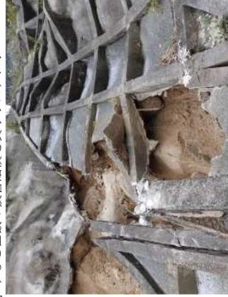
モルタル吹付工背面の地盤が劣化すると崩壊が起きる。しかし、モルタル吹付工の背面は目視調査では見えない。赤外線サーモグラフィで空洞発生は調べられるが、背面地盤の劣化はわからない。
