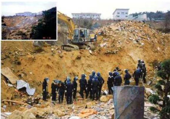
左の写真は、阪神・淡路大震災時の仁川百合野町の滑動崩落現場です。土の中に埋まっている犠牲者34名は、盛土上の住民ではなく、盛土の下流域の住民でした。盛り土上の住民は、法制度上は「加害者」の立場です。行政が作成する盛り土マップでは、しばしば加害者側に配慮して「安全」と評価する事例が多いように思われますが、個人からの依頼の場合、「外れたら損害賠償が待っている」と考え、慎重に評価する必要があります。
