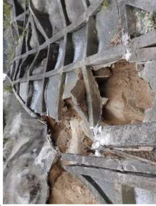
モルタル吹付工背面の地盤が劣化すると崩壊が起きる。しかし、モルタル吹付工の背面は目視調査では見えない。赤外線サーモグラフィで空洞発生は調べられるが、背面地盤の劣化はわからない。
