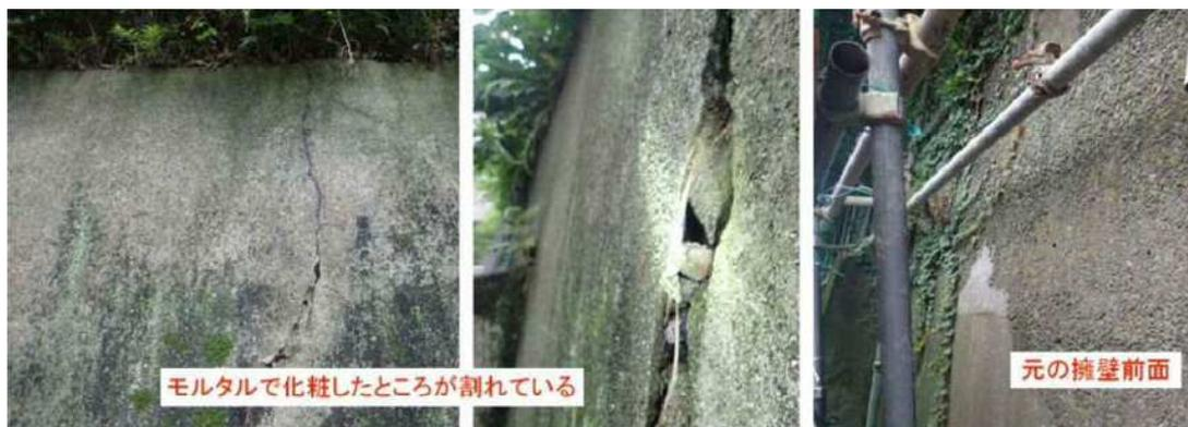
古いコンクリート擁壁で、表面のセメントが溶けて、骨材が目立つようになっていたため、建売業者が表面をモルタルで化粧した。元の擁壁とモルタルとの境界に水が進入し、押し出しクラックのような変状を呈したが、実際には本体の擁壁には変状は発生していなかった。
