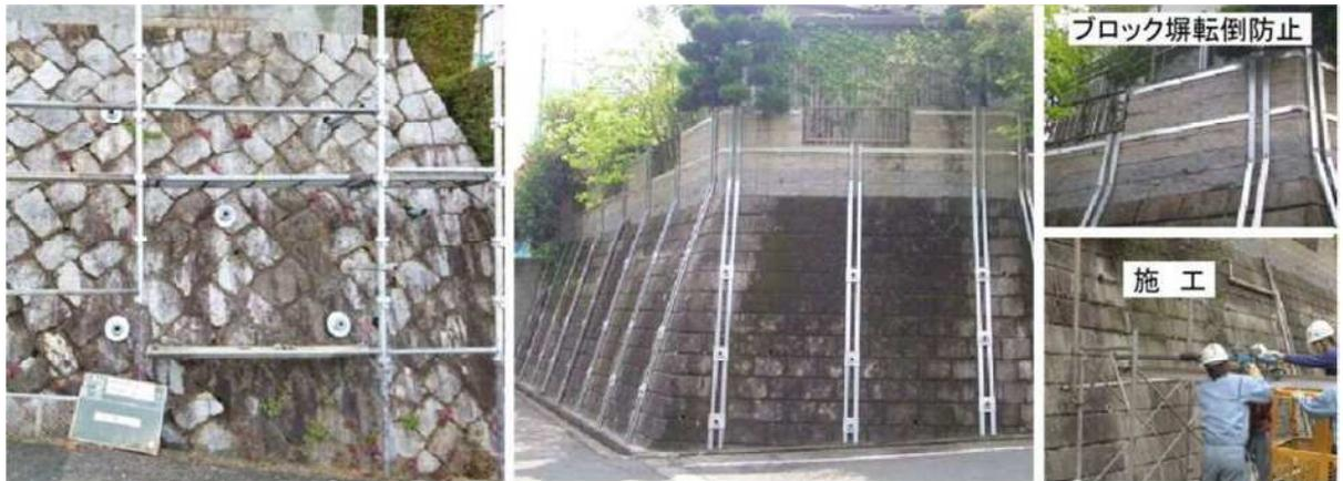
充填による補強工（対策効果を施工前後のS波速度によって評価する）
