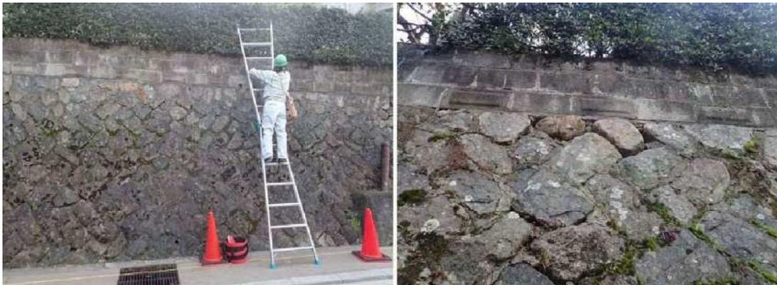
擁壁+ブロック塀の高さが高すぎる例（空積み擁壁を基礎としている点でもアウト。ただし、ブロック塀単体は高さが60cmしかなく、建築基準法上は基礎の規程が適用されない高さとなるため、ただちに違反建築物とはならない可能性がある）
